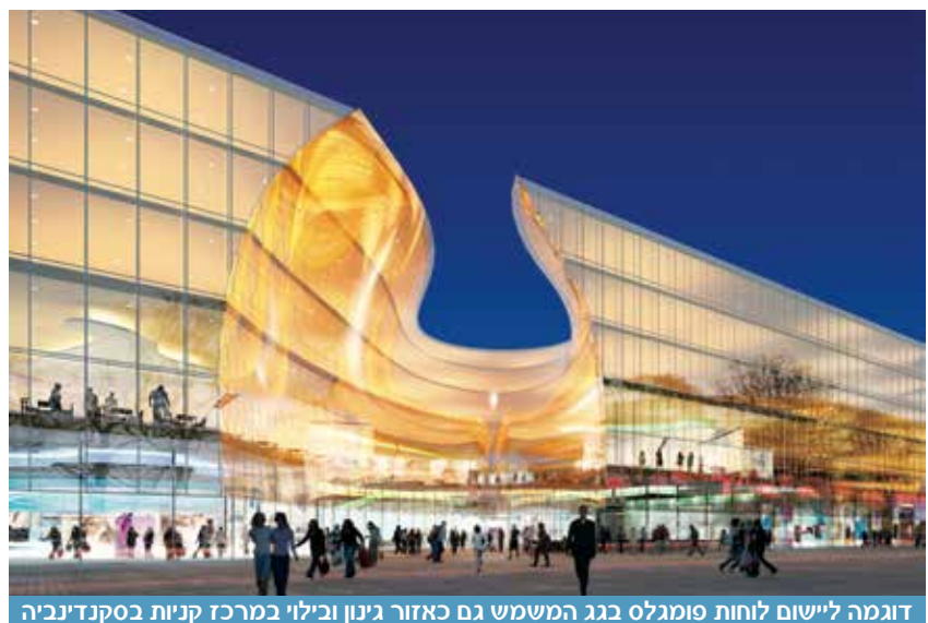
דוגמה ליישום לוחות פומגלס במשטחים א-סימטריים בגג מבנה, בכיכר לה דפאנס, פריז
